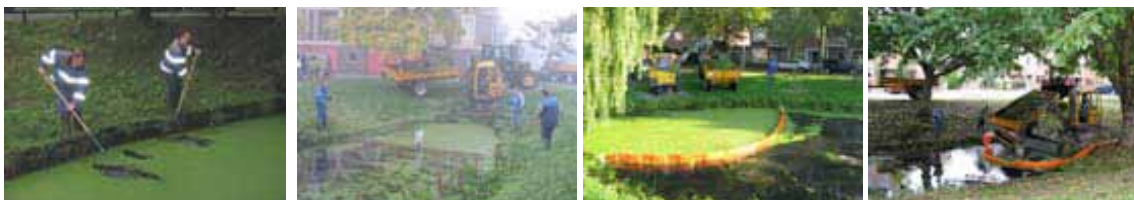
FIGUUR 6.1 HANDMATIG VERWIJDEREN VAN KROOS NA SAMENTREKKEN KROOS MET KROOSSCHERM
