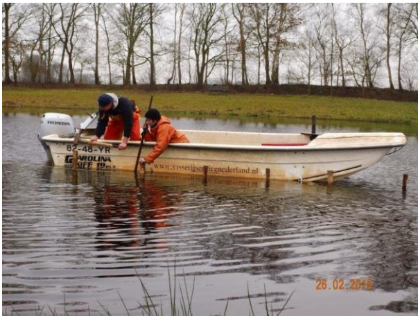
Plaatsen van de palen.
