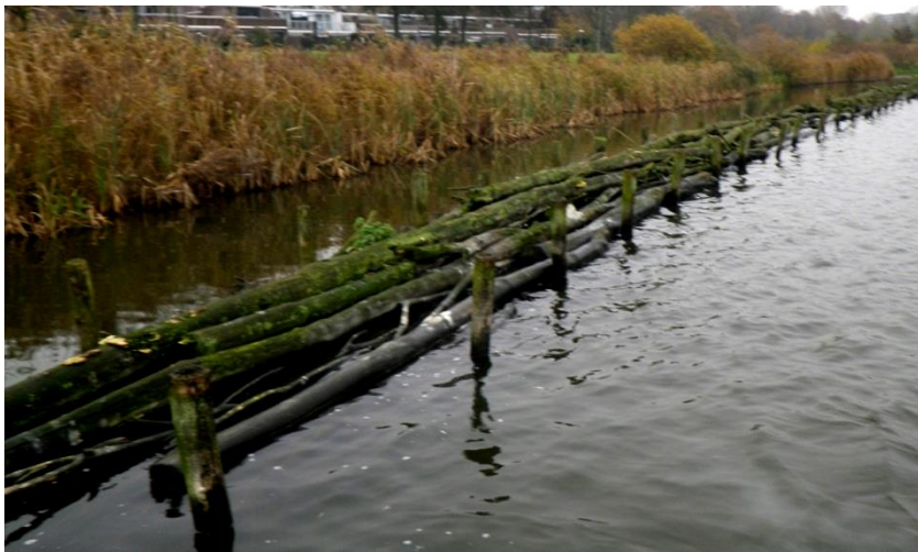
Figuur 7.3 Een dubbele palenrij met daartussen grof snoeihout, een goede schuilplaats voor jonge vis
